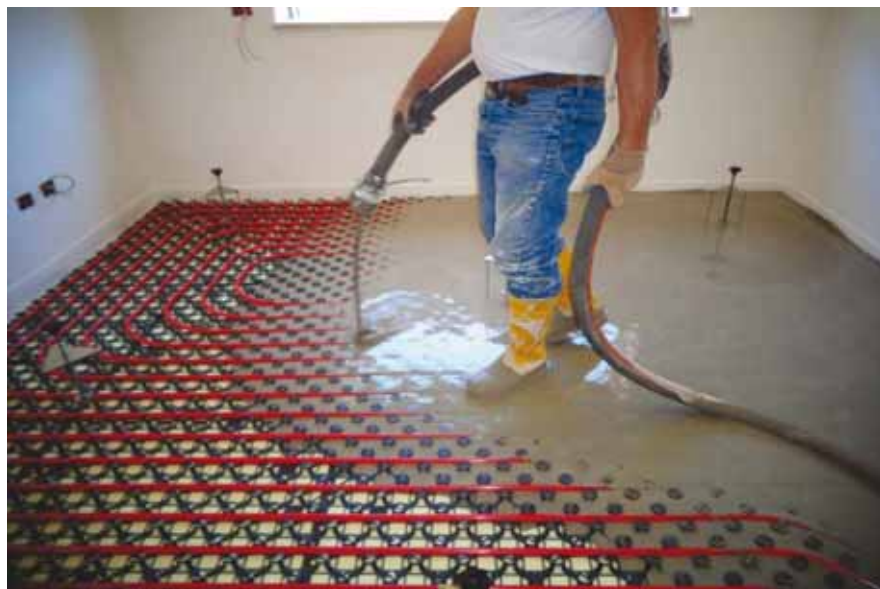
Esempi di impianti a pavimento radiante
