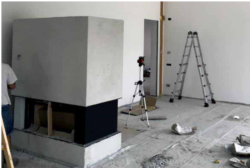
Inserto a legna con presa d'aria dedicata
